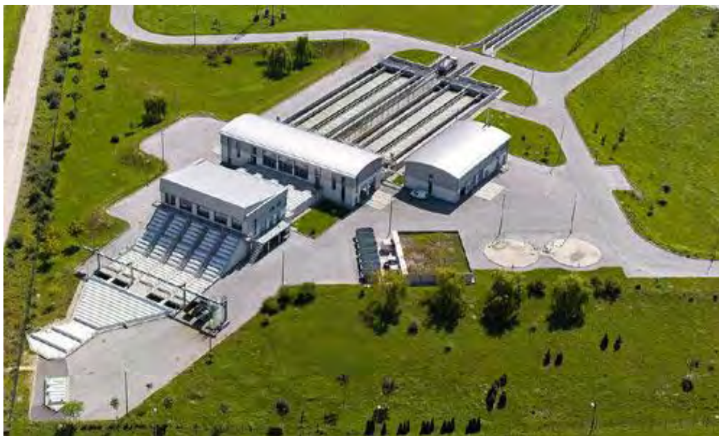
Slika 6. Mehanički dio uređaja za pročišćavanje otpadnih voda
