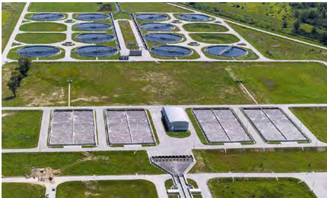
Slika 7. Biološki dio uređaja za pročišćavanje otpadnih voda
